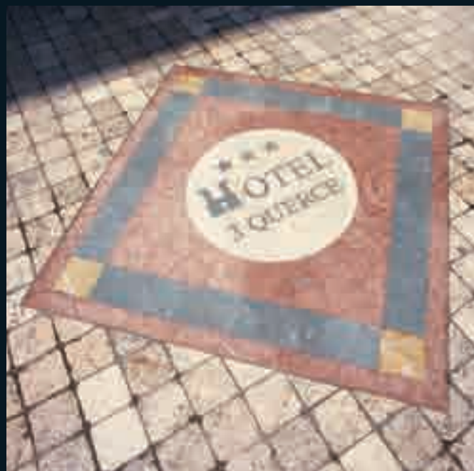
Hotel 3 Querce, Camerano - Ufficio Tecnico Bigelli marmi Realizzazione di gradini, pavimentazione e rosoni in pietra anticata
