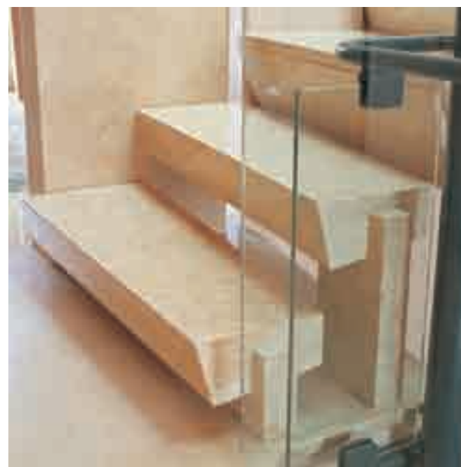
Arch. Rossini - Ing. Roccheggiani Realizzazione di scala a sbalzo in marmo rosa
