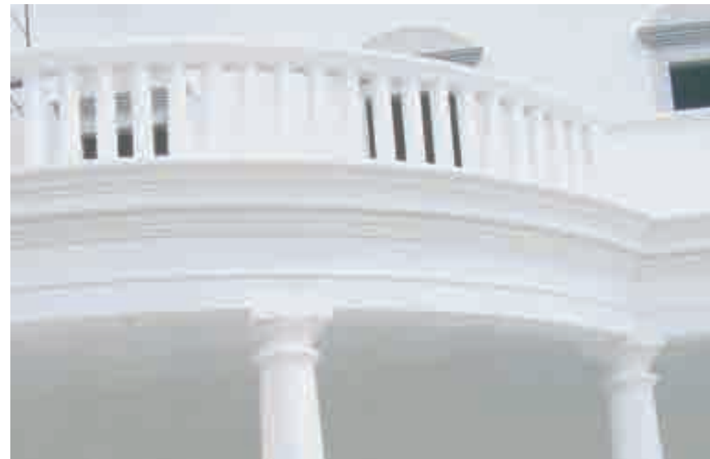
Arch. Salerno Realizzazione di gradinate esterne, colonne, capitelli e riquadratura portale
