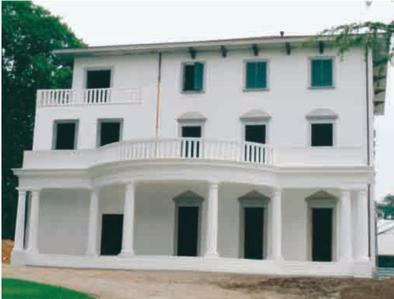
Arch. Salerno Realizzazione di gradinate esterne, colonne, capitelli e riquadratura portale
