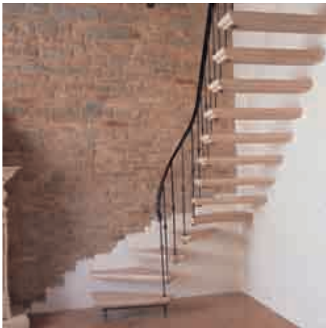
Arch. Fioranelli Realizzazione di scala a sbalzo in pietra tagliata al verso
