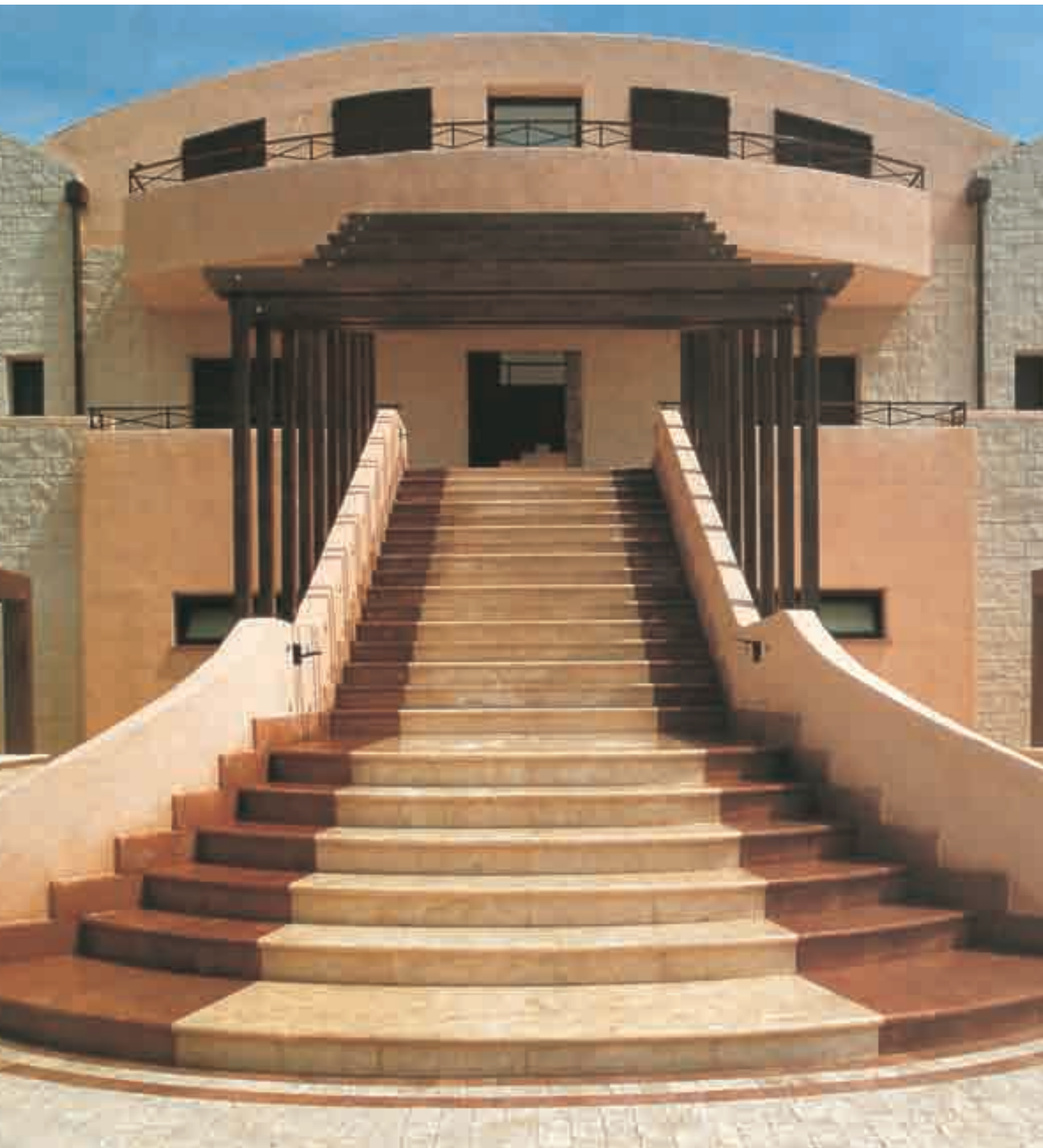
Geom. Ferri Realizzazione di gradini e pavimentazione in pietra antica
