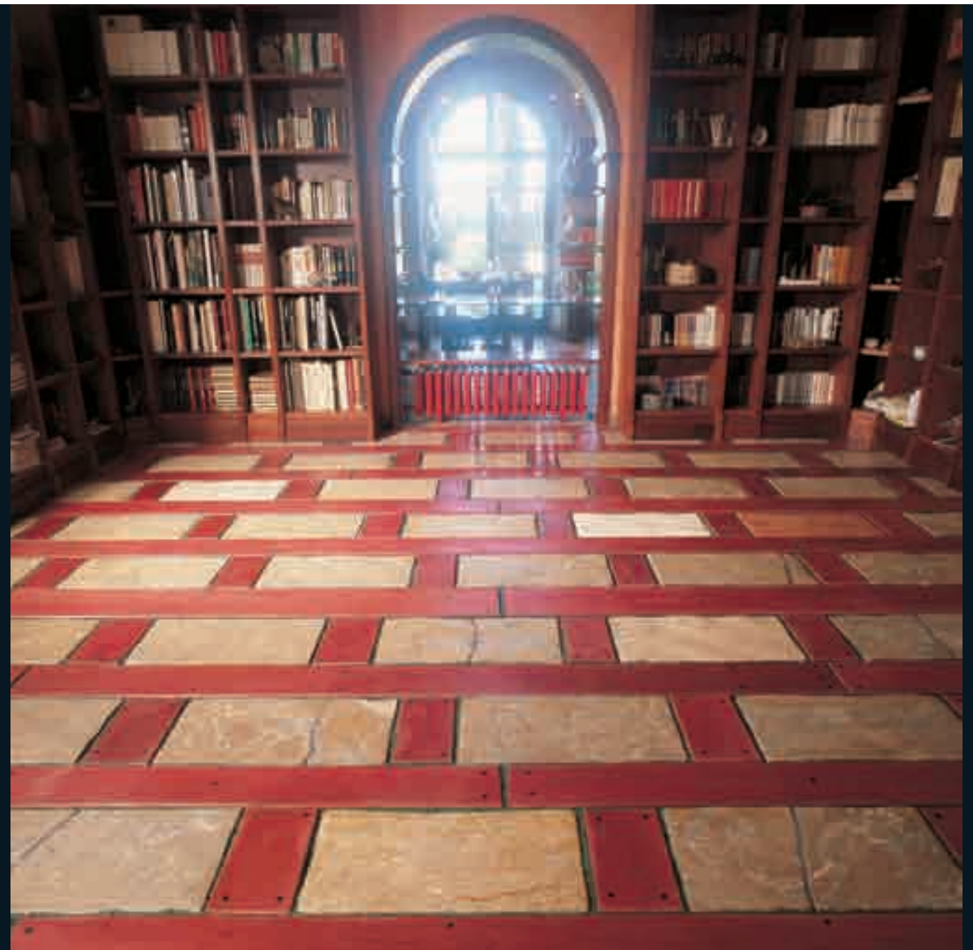
Ufficio Tecnico Bigelli marmi Realizzazione di pavimentazione in pietra scalibrata ed anticata con inserti in legno
