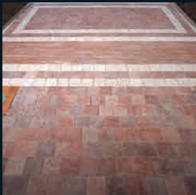
Geom. Ferri Realizzazione di gradini e pavimentazione in pietra anticata
